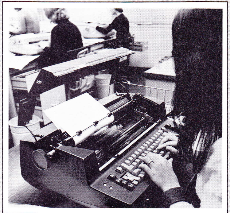
Bij de meeste op de typekamer in gebruik zijnde machines staan de lettertjes niet op zogenaamde „hamertjes”, maar op een bolletje, dat met een razende snelheid van links naar rechts langs het vel papier glijdt.
